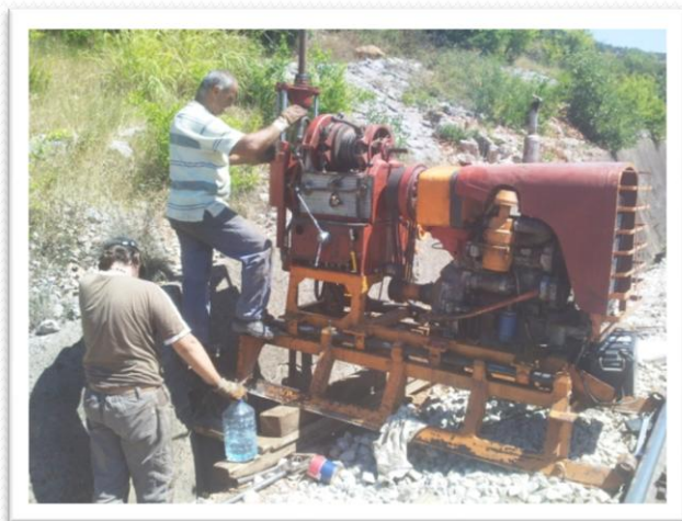
Bušaća garnitura "u radu" u kanalu potpornog zida
