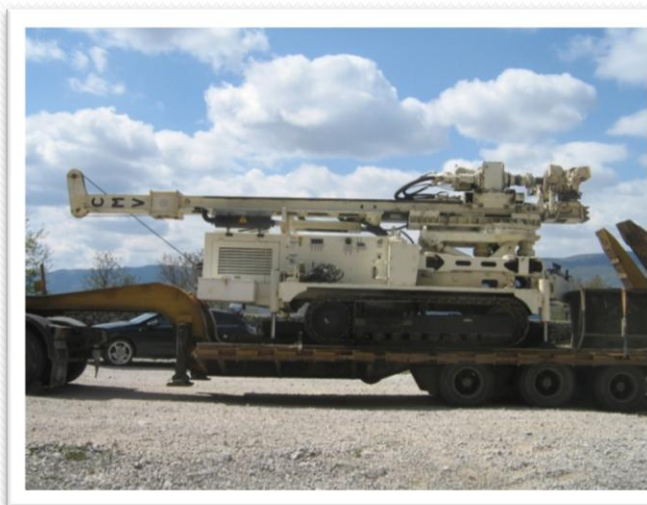
Transport bušaće garniture na gradilište
