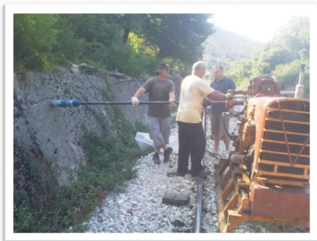
Uzimanje betonskih uzoraka sa strane potpornog zida
