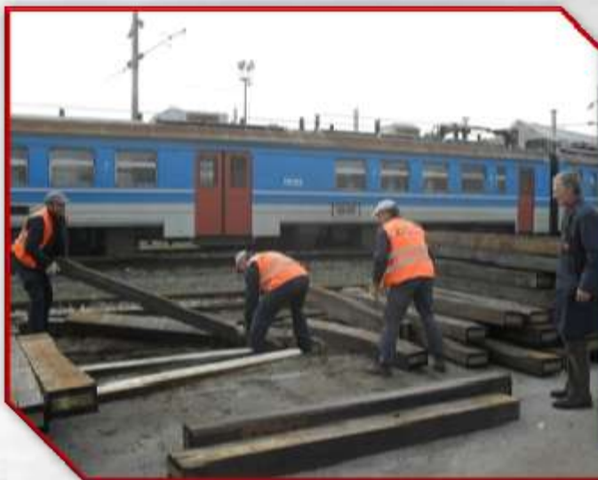
U stanici Podgorica, vršeno je uređenje stanicnog plataa slaganjem novih drvenih pragova
