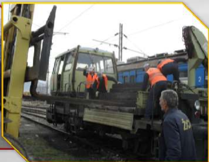
U stanici Podgorica, vršeno je uređenje stanicnog plataa slaganjem novih drvenih pragova
